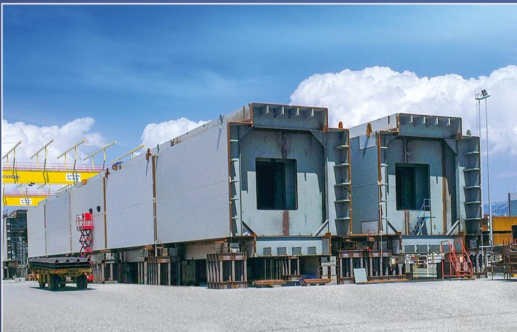
**ПРОБНАЯ СБОРКА БАШЕННЫХ БЛОКОВ**
