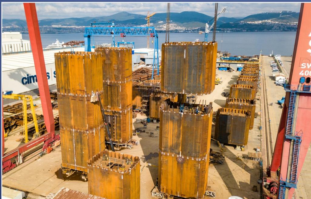
**ПРОБНАЯ СБОРКА БАШЕННЫХ БЛОКОВ**
