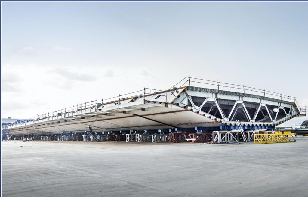
**ПРОБНАЯ СБОРКА БАЛОЧНЫХ БЛОКОВ**
