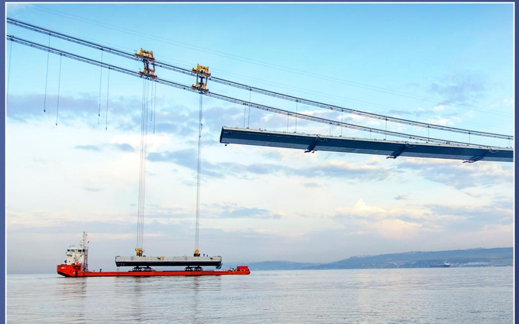
**ТРАНСПОРТИРОВКА БАЛОЧНОГО БЛОКА**
