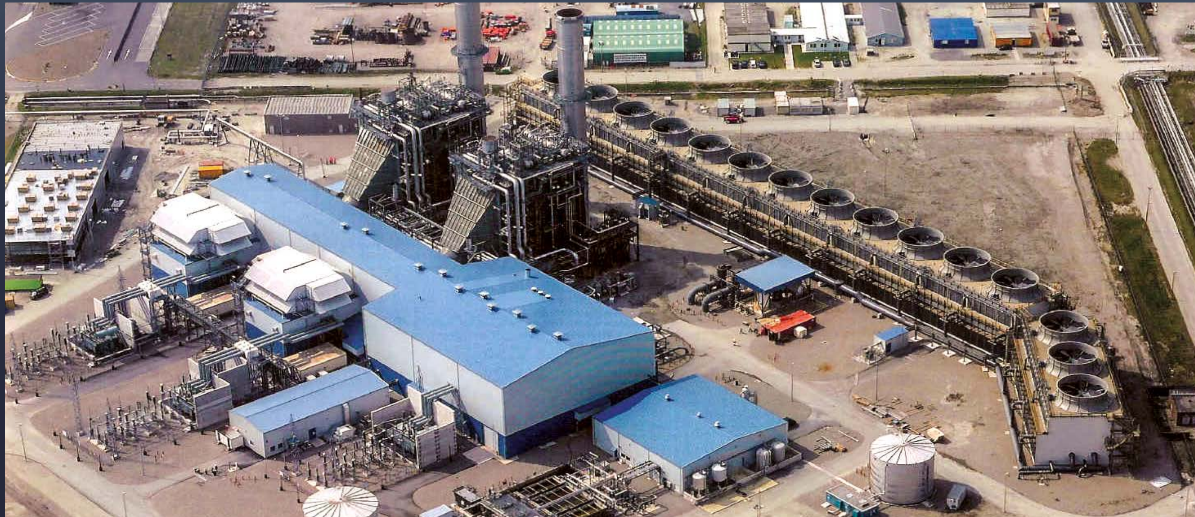
RIJNMOND CCPP 770 MW
